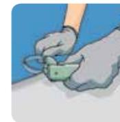
Devido ao processo de armazenamento vertical, as bordas das mantas sofrem naturalmente pequenos danos, como amassamentos ou impregnação de sujeira. Por isso, devem ser refileadas em pelo menos 1 cm para melhorar a segurança da solda (fria ou quente). Este processo pode ser feito com um corta bordas ou com estilete, auxiliado por uma régua de metal. **IMPORTANTE:** Não refilar Decorflex® e Imagine®.
