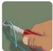
e. Corte o excesso do cordão de solda com o cabo exato e o auxílio de uma lâmina externa quadrada.
