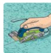
**15.7.** Corte a borda sobreposta com o auxílio do cortador de juntas Linocut. Regule a ferramenta para evitar que a emenda fique demasiadamente justa. Você poderá também utilizar um estilete e régua de metal. Remova as sobras;
