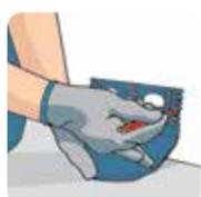
a. Com o auxílio de uma régua de metal ou do marcador de rodapé, trace na parede a altura do rodapé prevista em projeto;
