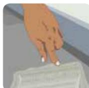
**g.** Verifique o tack do adesivo após 15 minutos da aplicação. Se houver pega mas os dedos ficarem limpos, inicie a aplicação do produto. Se o adesivo ainda estiver úmido e a instalação for iniciada, poderão ocorrer bolhas ou descolamento.
