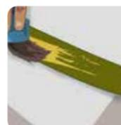
**21.3.** Aplique adesivo de duplo contato sem toluol nas paredes e no verso do rodapé (que deve estar limpo e livre de pó). Aguarde 15 minutos e cole o rodapé encostando a parte superior junto à linha e depois encaixe a parte de baixo;
