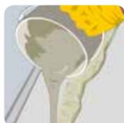
**a.** Começando do eixo marcado previamente e utilizando uma desempenadeira dentada A4, espalhe o adesivo seguindo as informações de rendimento para cada tipo de produto;
