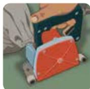
**16.1.1.** Utilize sempre a fresa elétrica para assegurar uma cavidade uniforme e de seção circular. A fresa em paredes deve ser feita com fresador manual tipo L;
