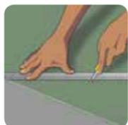
17.2. Com auxílio de um estilete, corte a fita crepe exatamente na emenda das mantas;
