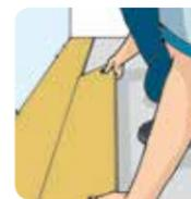
**25.5.** Para iniciar a segunda fileira, meça o ponto médio da primeira régua. Corte uma régua nesta medida, e encaixe no comprimento da primeira régua. Para as próximas réguas, sempre inicie o encaixe pelo topo e depois encaixe o comprimento. Levante o conjunto para um melhor encaixe, caso necessário;
